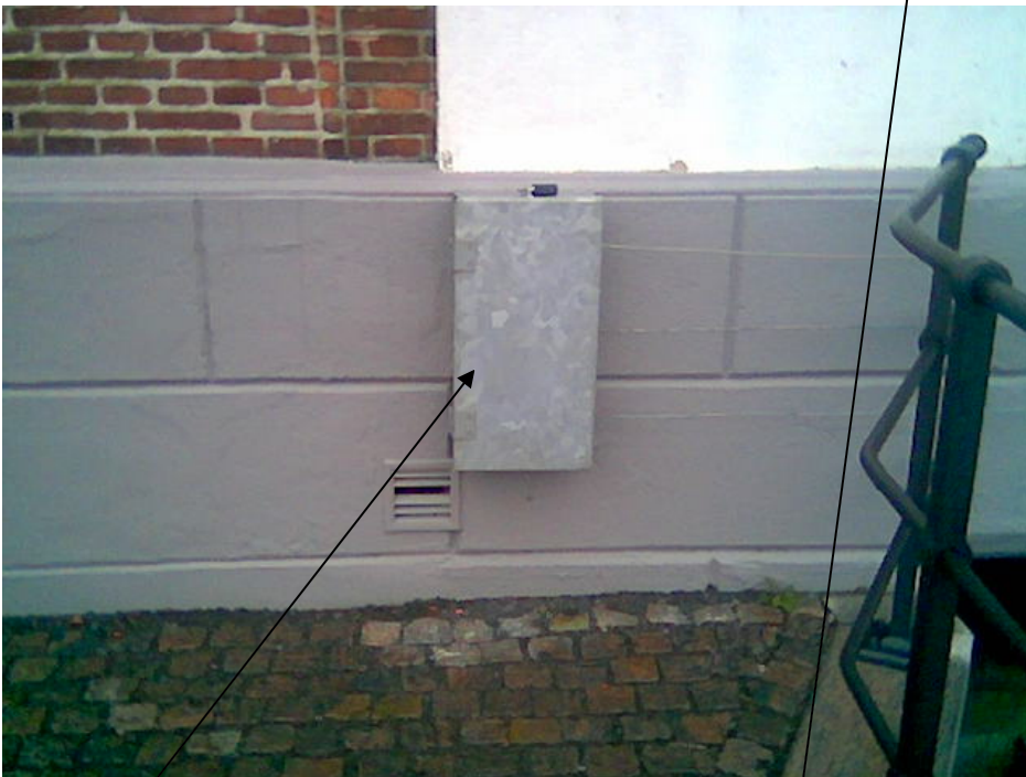
Kasse som skjuler spil hvor man betjener skodder
